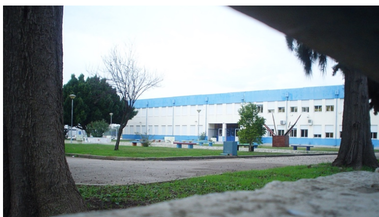
Figura 9 – Vista do exterior da EB de Castro Marim.
