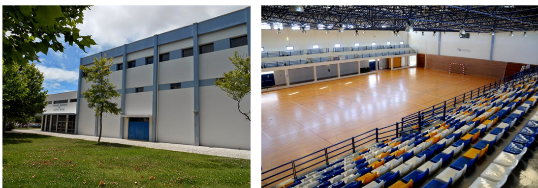
Figura 32 e Figura 33 – Vista exterior e interior do Pavilhão Desportivo de Castro Marim.
