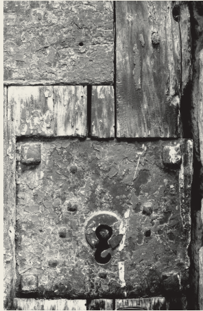
Figura 1. Fotografia de Tomas Castelazo, Detalle de la puerta de la celda 18 de la vieja cárcel de León , Guanajuato, Mexico (2009).
