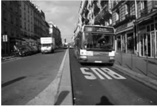
Photo 5 : Couloir de bus protégé par un séparateur
