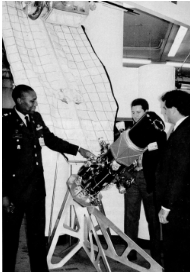
Abb. 12: KE-ASAT-Kill-Vehicle von Boeing/US Army mit Segel zur Beschädigung des am oberen Bildrand dargestellten Ziels
