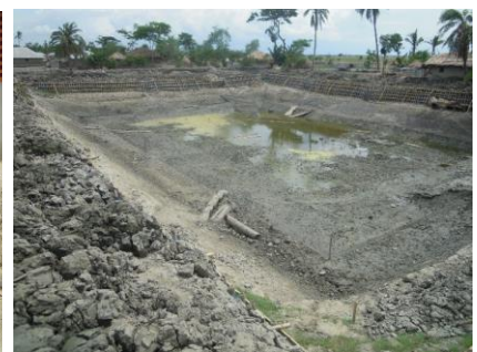
Reinigungsmaßnahme der Trinkwasserteiche
