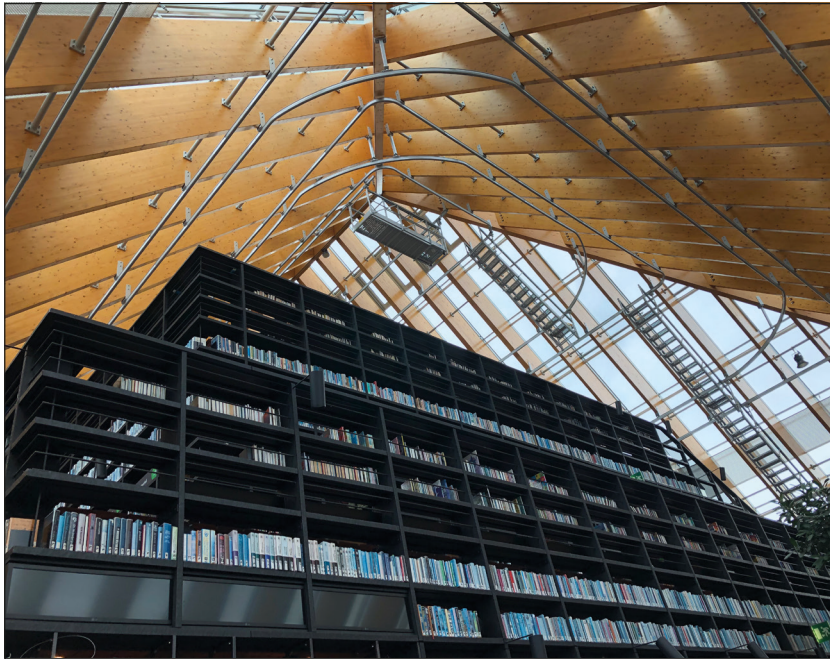
Abb. 8: De Boekenberg, Spijkenisse, Foto: Gemeinsame Baukommission von VDB und dbv
