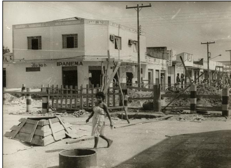
Figura 10: Construção do Calçadão de Imperatriz
