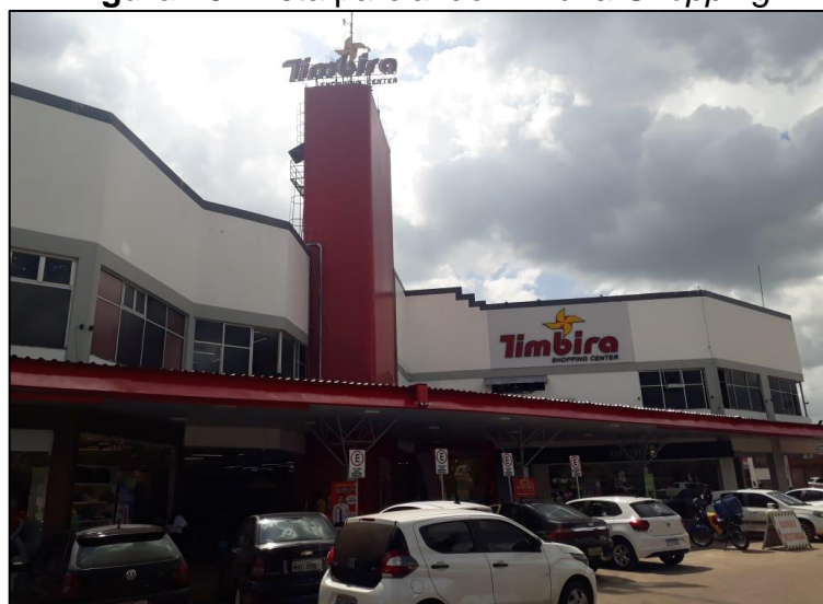
Figura 18: Vista parcial do Timbira Shopping
