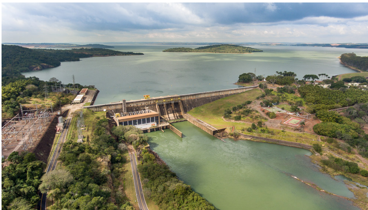
Figura 4.4: Usina Hidrelétrica Jurumirim. Fonte: (CTG BR, 2019)
