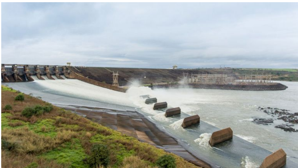
Figura 4.2: Usina Hidrelétrica Capivara. Fonte: (CTG BR, 2019)
