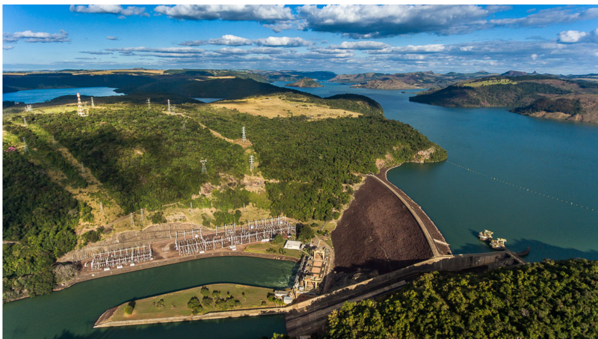
Figura 4.3: Usina Hidrelétrica Chavantes.
