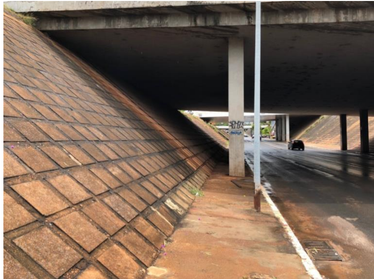
Figura 4 – Viaduto 2 na Via S2, Asa Sul
