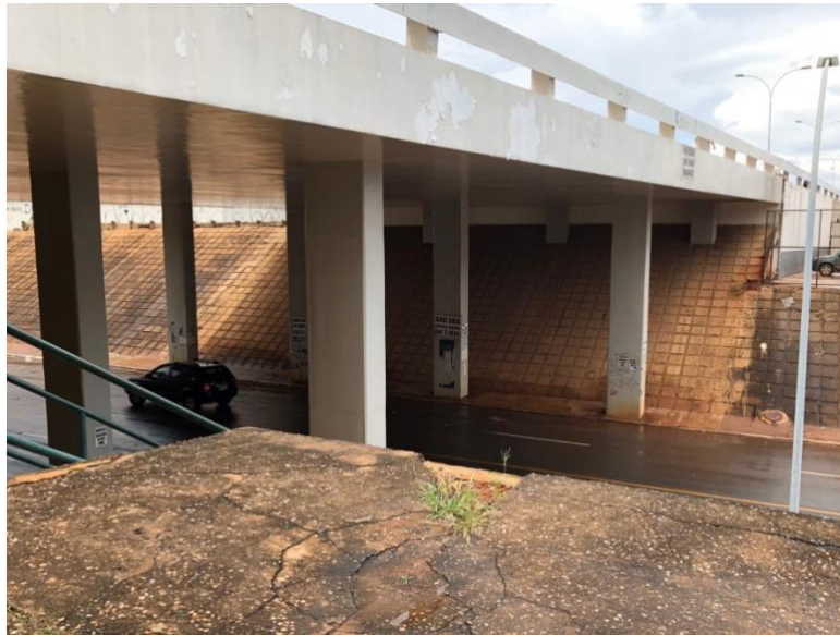
Figura 2 – Viaduto Via S2, Asa Sul (Visão Ampliada)
