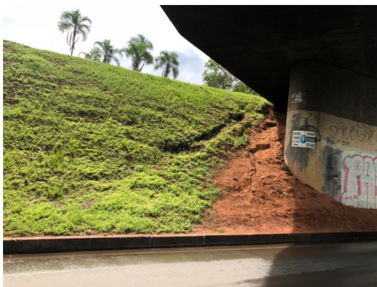
Figura 1 – Viaduto L2 Sul para W3 Sul
