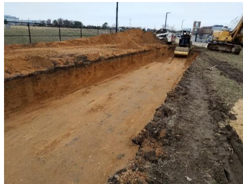
(d) Compaction Process
