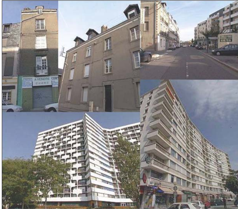
Figure 23. Quelques constructions représentatives du secteur
