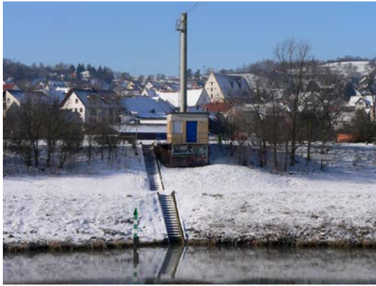
Abb. 5: Pegel Trunstadt mit Seilkranmessanlage bei Main-km 378,44
