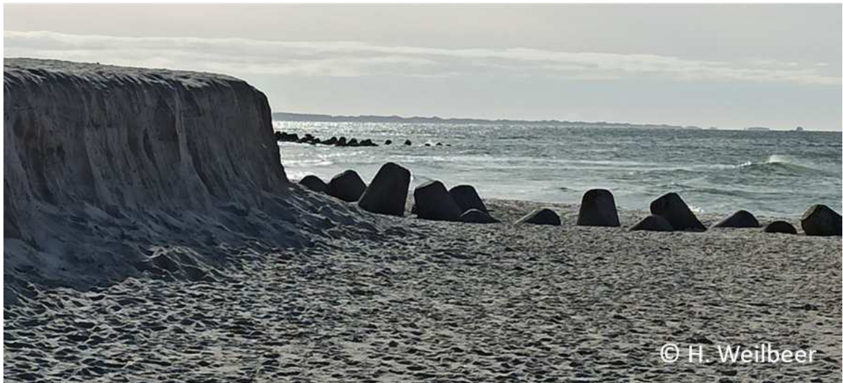
Bild 1: Mit der Anordnung von Tetrapoden, unterstützt durch regelmäßige Aufspülungen großer Sandmengen, wird versucht, die Südspitze der Insel Sylt vor Erosion durch Strömung und Seegang zu schützen.
