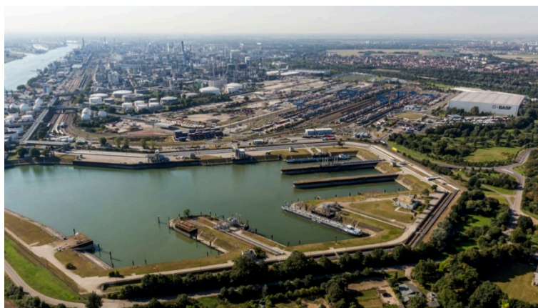
Ansicht von Norden auf das Werksgelände der BASF SE in Ludwigshafen. Im Vordergrund ist der Nordhafen der BASF SE zu sehen und dahinter das Kombi-Verkehrsterminal.
