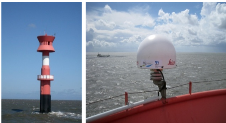
Abb. 1: GNSS-Station Pegel Dwarsgat (Außenweser) (Fotos: Weiß, BfG)
