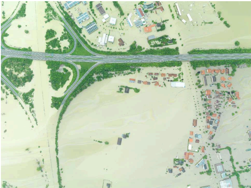
Abbildung 5: Überflutung durch das Hochwasser im Bereich Deggendorf am Autobahnkreuz A3/A92 am 6. Juni 2013.
