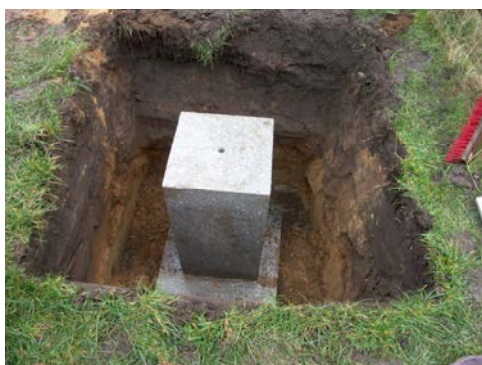
Abb. 2: Vermarktungsträger eines Geodätischen Grundnetzpunktes (GGP)
