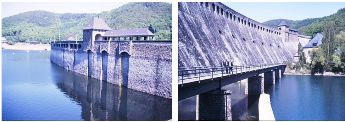
Abb. 5: Bauwerksmonitoring an der Edertalsperre
