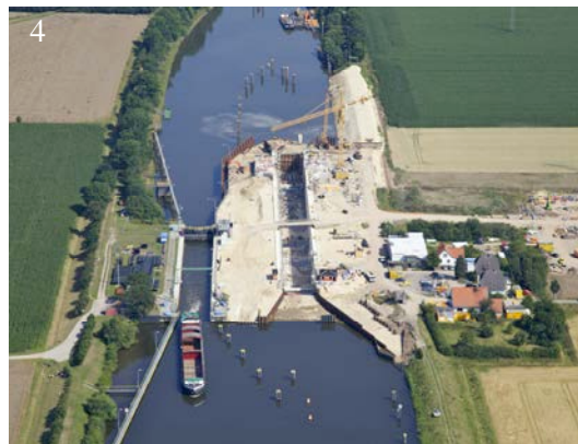
Abb. 2-4: Luftbilder der Baumaßnahmen Neubau der Weserschleuse Minden (2), Neubau Schleuse Bolzum (3), Neubau Schleuse Dörverden (4)
