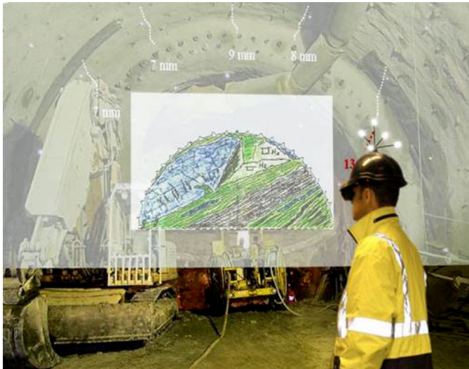
Abb. 6: Absteckung von Information als Überlagerung der Realität (Geodata ZT GmbH, 2012)
