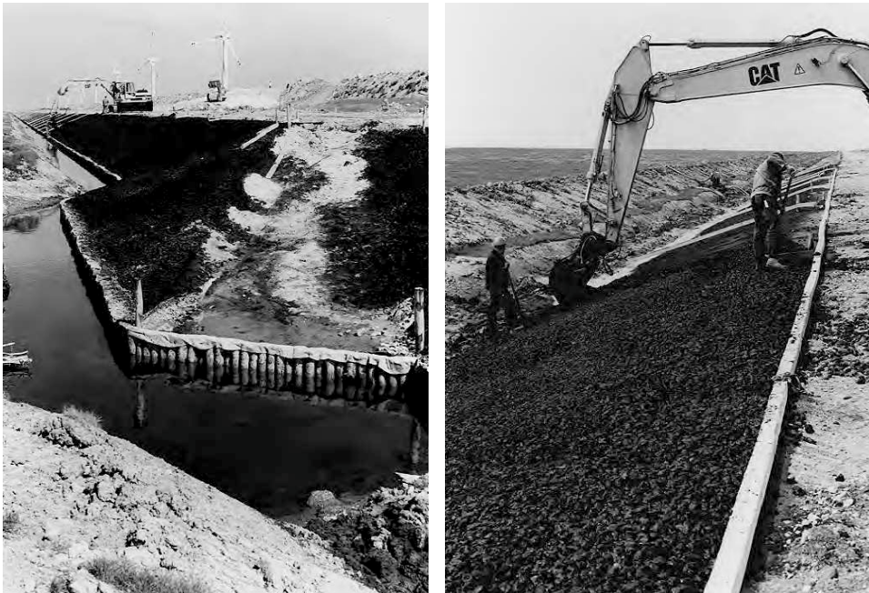
Abb. G 50b+c: Deichverstärkung Friedrich-Wilhelm-Lübke-Koog hinter Vorland 2001/2002: Einbau von Mastixschotter als Fußdeckwerk auf Bitumensand-Filter bis zur Überschlaggerung
