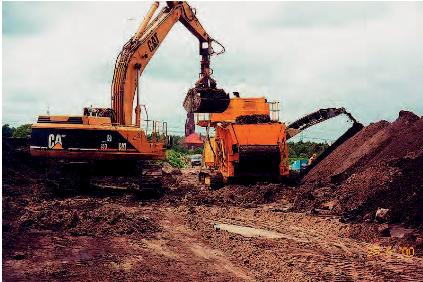
Abb. G 48g: Bodenverbesserung durch Aufbereitungsgeräte
