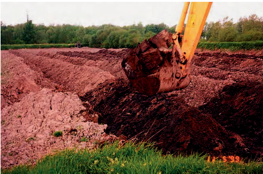
Abb. G 48e: Umsetzen von Mieten in einer Deponie
