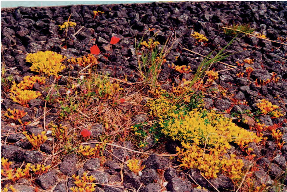
Abb. G 51b: Deichverstärkung Tümlauer Koog 1994/95 (Westabschnitt), Stat. 2+660 bis Stat. 2+860: Deckwerk aus 20 cm Mastixschotter auf der Außenböschung bis zur Dammkrone – wasserdurchlässig und begrünt
