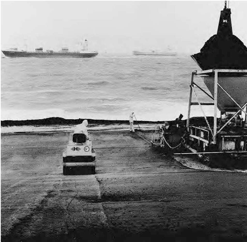
Abb. G 49b: Raupengeführter Vertikalfertiger im Einsatz (CUR, 1995)
