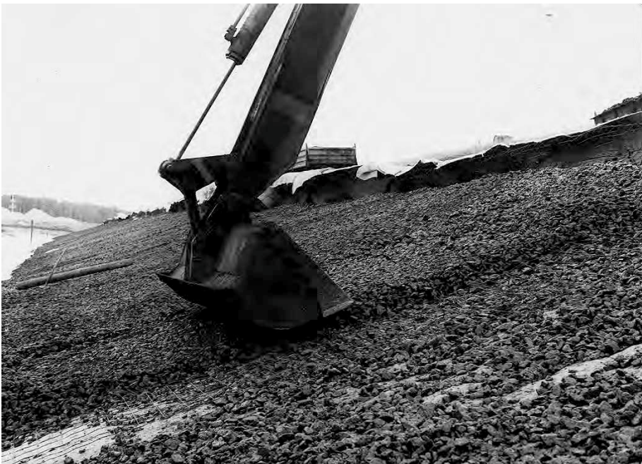
Abb. G 53: Verlegen von Mastixgestein mit dem Hydraulikbagger, leichtes Andrücken mit der leeren Schaufel
