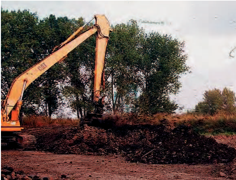
Abb. G 48f: Bodenverbesserung durch Fräsen
