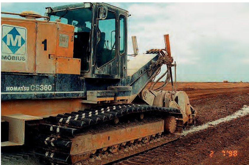
Abb. G 48h: Verbesserungsmaßnahmen durch Fräsen
