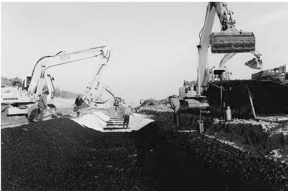
Abb. G 55a: Deich im Tidebereich des Elbe-Ästuars bei Glückstadt mit höherem Vorland, deshalb mit einem wasserseitigen Entwässerungsgraben mit einem erosionsfesten offenen Deckwerk aus Mastixgestein auf geotextilem Filter zur schnelleren Wasserabführung
