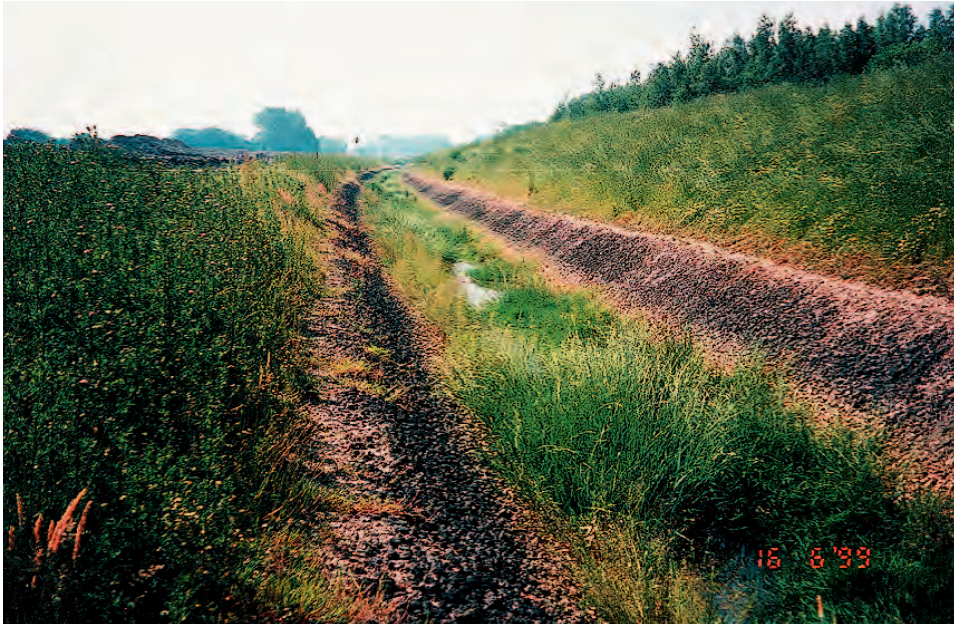
Abb. G 55b: Deich im Tidebereich des Elbe-Ästuars mit höherem Vorland bei Glückstadt, wasserseitiger Entwässerungsgraben zur schnelleren Wasserabführung: Begrüntes offenes Deckwerk aus Mastixgestein
