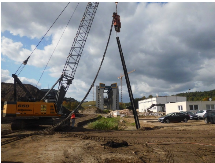
Bild 1: Ausgerüttelter Probepfahl.
