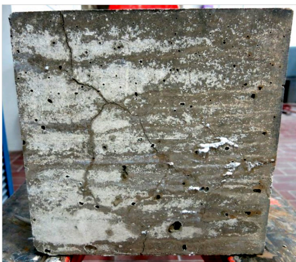
Bild 1: Prüfkörper Performance-Prüfung mit AKR-typischen Netzrissen.
