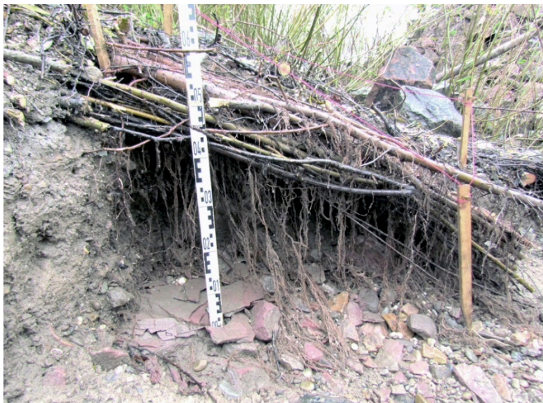
Bild 1: Freigespülte Wurzeln einer Weidenspreitlage am Rhein.
