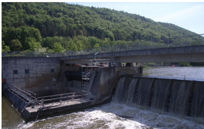
Bild 1: Zur Bauwerksinspektion trockengelegtes Wehrfeld der Wehranlage Dietfurt.
