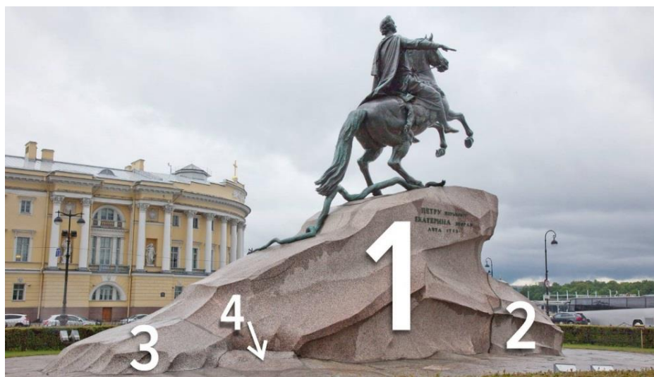
Рис.1. Блочное строение постамента Медного всадника. Фото Г.Н.Попова, 2016 г.
