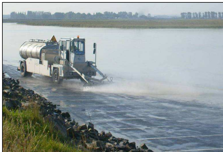
Figure 9 : Après chaque grande marée recouvrant les parkings entourant le Mont-Saint-Michel, les sédiments apportés par le flot sont repoussés pour empêcher leur accumulation.
