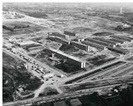
Le chantier du campus de Beaulieu en 1963
