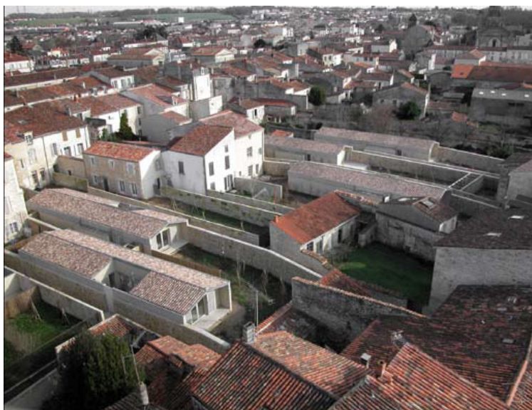
Figure 15 Commune de Saintes, densité et qualité de vie. Source: Visions, 2007. Photo : Ph. Babled Nouvet Reynaud Architectes
