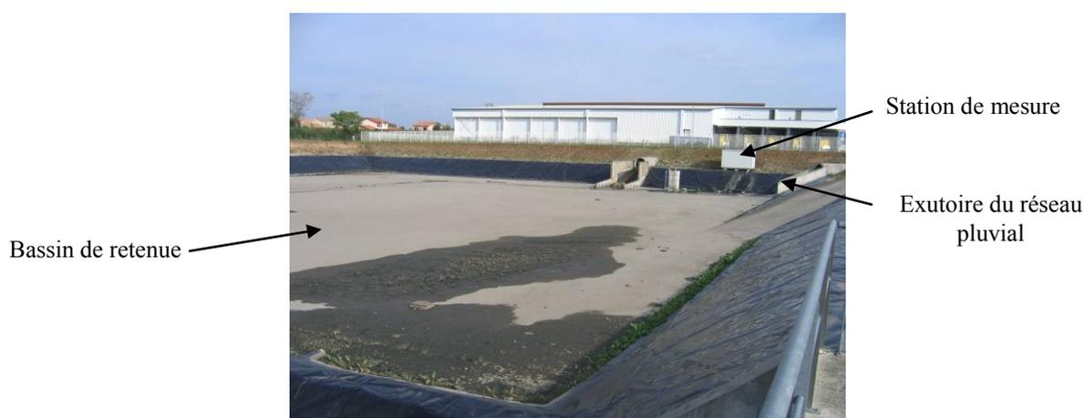
Figure 7.6. Photographie de la station de mesure installée en entrée du bassin de retenue décantation à Chassieu
