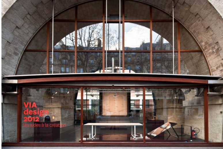
Figure 16 Viaduc des Arts
