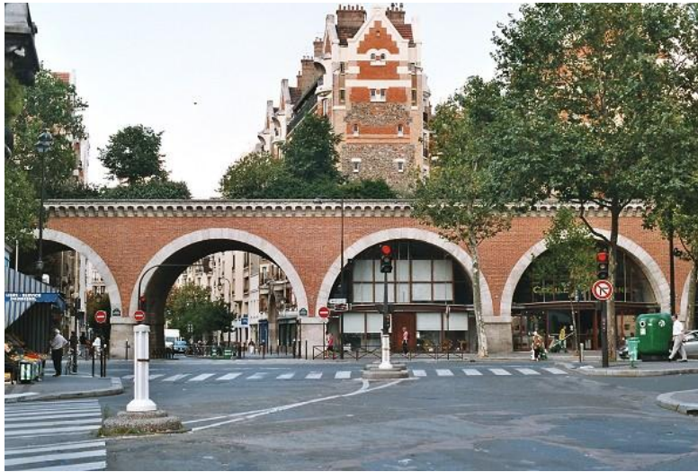
Figure 17 Viaduc des Arts
