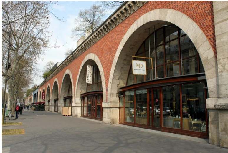
Figure 15 Viaduc des Arts
