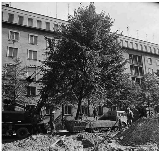
Il. 8a. Przebudowa alei Róż, przygotowanie placu do montażu pomnika Włodzimierza Lenina, wykopane drzewo przygotowane do transportu, fot.: J. Podlecki, 1970 r. Źródło: ze zbiorów Muzeum Krakowa (nr inw. MHK-991/XI f/12).
