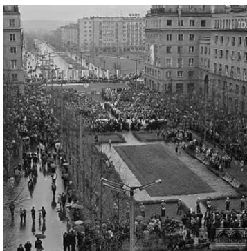
Il. 7b. Pierwsze prace ziemne związane z budową pomnika Lenina, sierpień 1972 r., centralnie usytuowana kwaterna trawnikowa, fot.: J. Podlecki. Źródło: ze zbiorów Muzeum Krakowa (nr inw. MHK-963/XI f/4).
