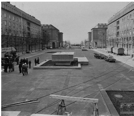
Il. 8b. Ustawianie pomnika Lenina przy alei Róż; z każdej strony wzdłuż pierzei pozostał jeden szpaler lipowy; nawierzchnia z płyt w dwóch kolorach tworzy wzór kraty; na dole z prawej fragment rabaty, fot.: J. Podlecki, 16.04.1973. Źródło: ze zbiorów Muzeum Krakowa (nr inw. MHK-997/XI f/2).
