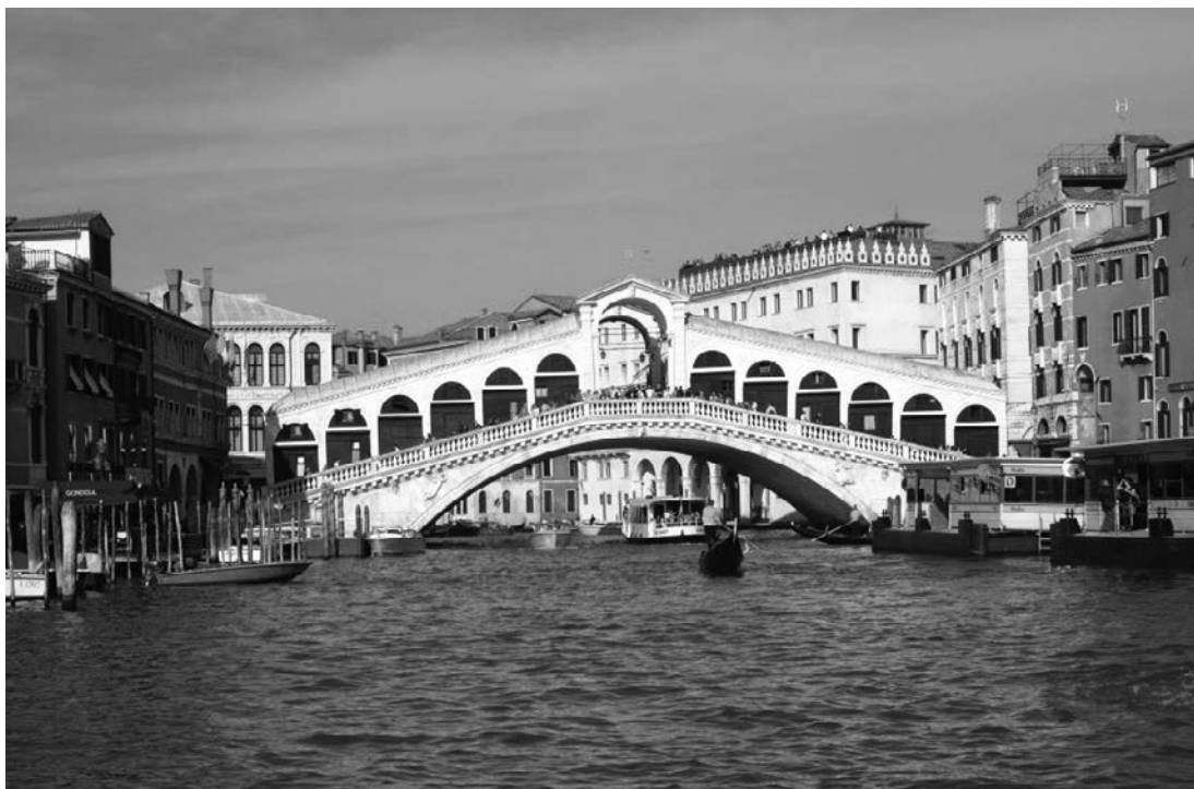
Il. 5. Ponte di Rialto w Wenecji to jeden z pierwszych i niewątpliwie najbardziej znanych living bridges , który jest podtrzymywany przez jeden łuk o długości 28 metrów i wysokości 7,5 metra przerzucony nad Canal Grande. Trzy równoległe biegi schodów obsługują most. Źródło: Ponte Rialto created by ea8322 , www.pxleyes.com/photography-picture/5b4b74abbe0f9/Ponte-Rialto.html [dostęp: 16.07.2019].
