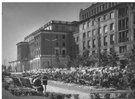
Il. 12a. Nowa Huta, aleja Róż, obsadzenia centralnej kwatery, fot.: H. Hermanowicz, 1. poł. lat 60. XX w. Źródło: ze zbiorów Muzeum Krakowa (nr inw. MHK-4156/N/3).
