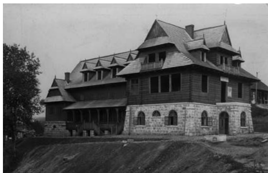
Il. 4. Worochta, Dom Ludowy w trakcie budowy, 1929 r., fot.: Adolf Błaż, proj.: Kajetan Petrowicz (?), ok. 1926 r. (Narodowe Archiwum Cyfrowe, sygn. 3/1/0/10/3968/1)
