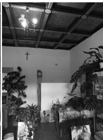
Il. 12. Worochta, pensjonat o nieznanym nazwie z apteką, wnętrze dawnego pomieszczenia aptecznego ze stropem kasetonowym, 2009 r., fot.: J. Czubiński
