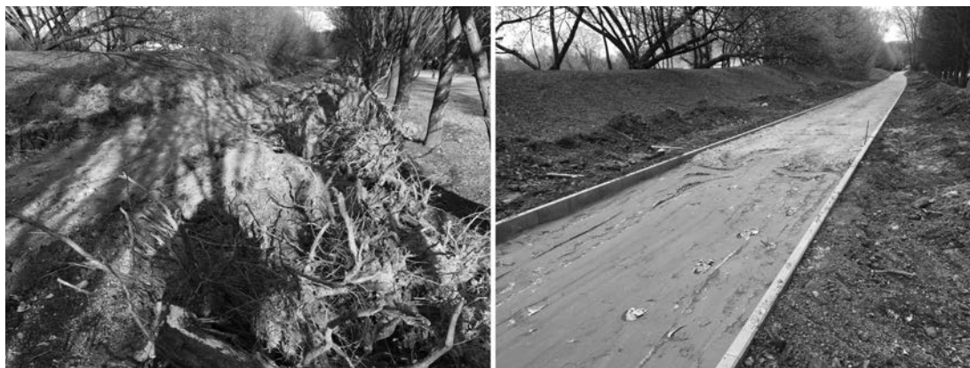
Il. 10. Budowa drogi rowerowej w sąsiedztwie szpaleru dębów szypułkowych odm. fastigiata , Pole Mokotowskie, Warszawa – drastyczne cięcia korzeni drzew, 03–04.2017 r., aut. fot.: J. Łukaszkiwicz
