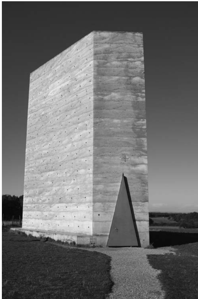
Il. 2. Polna kaplica brata Mikołaja, Wachendorf 2007, architekt: Peter Zumthor, fot.: jda, źródło: Wikimedia Commons, https://commons.wikimedia.org/wiki/File:Bruder_Klaus_Feldkapelle.JPG [dostęp: 1.03.2021].
