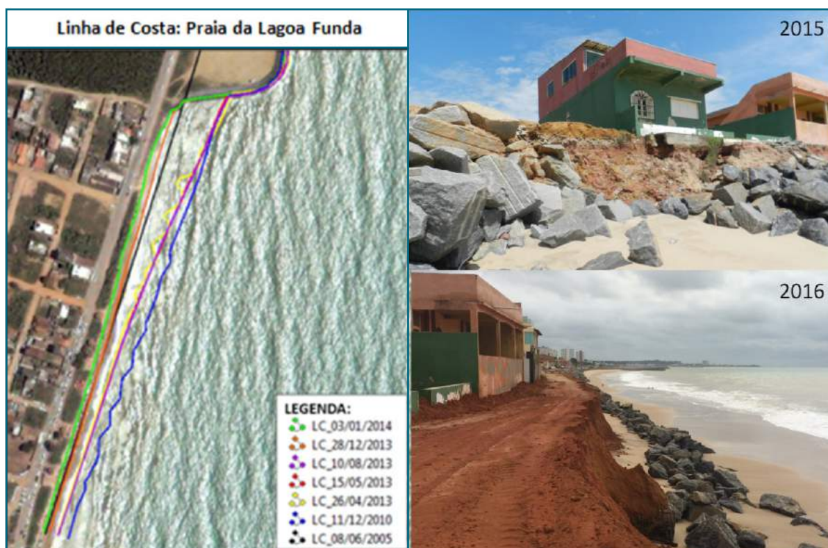
Figura 5. Variação espacial e temporal da linha de costa da Praia da Lagoa Funda. Destruição da avenida beira-mar entre os anos de 2015 e 2016 e recuperação por alimentação artificial de sedimentos (Vanessa Menezes). Fonte: Relatório Técnico COGEST N° 001-2015 do Instituto Estadual do Meio Ambiente (IEMA).
