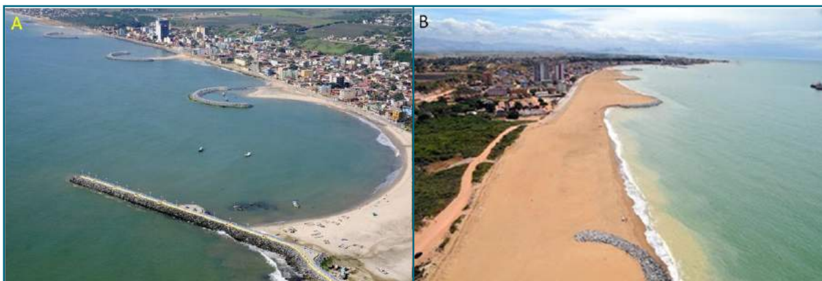
Figura 4. Estruturas de engenharia rígida na Praia Central.
