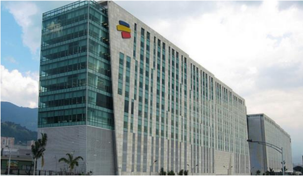
Figura 6 Edificio Bancolombia Medellín
