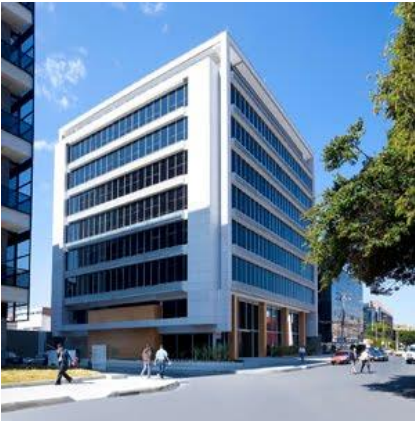
Figura 5 Edificio Novartis, Bogotá
