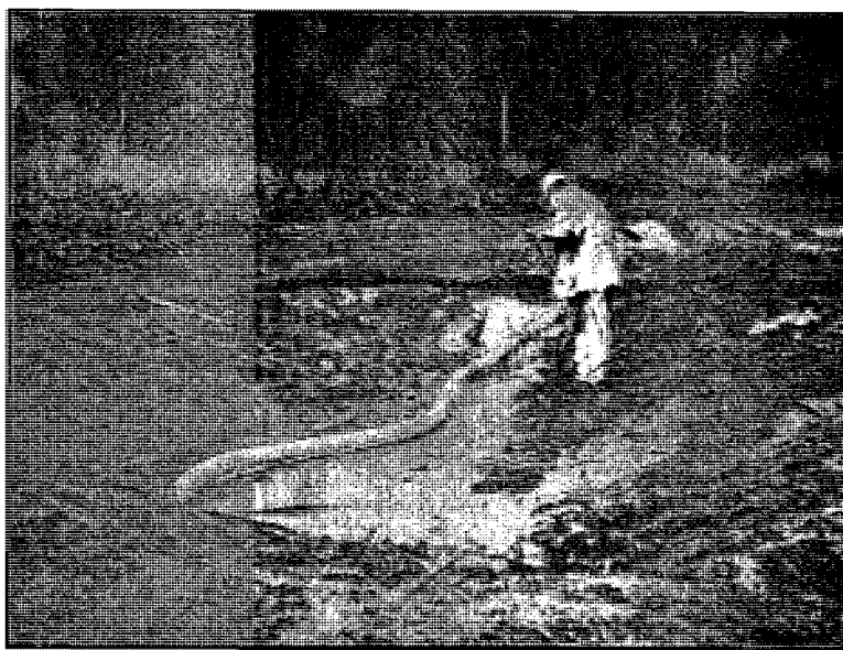
Figure 3.17 : Pose du drain
