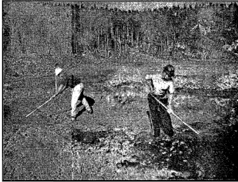
Figure 3.9: Nettoyage de la zone excavée au moyen de râteaux, afin d'enlever les particules grossières qui peuvent être susceptibles de perforer la géomembrane.
