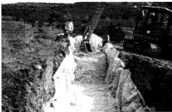
**Figure 2.2 :** Remplissage de la tranchée d'un DAC par de la pierre calcaire (tirée de WVU, 2008).
