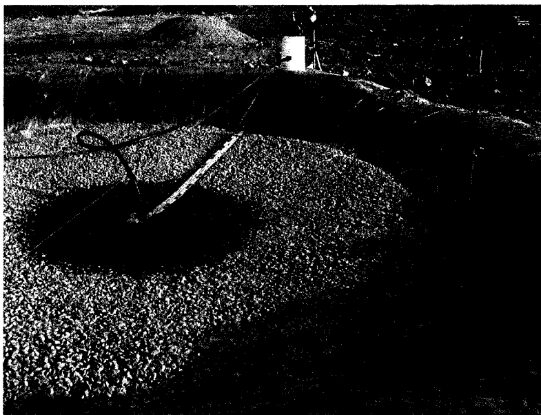
Figure 6.1 : Essai d'infiltration (à grande échelle) à travers une surface conique avec mesure de la hauteur d'eau en fonction du temps (les données de cet essai sont présentées à l'annexe 2)
