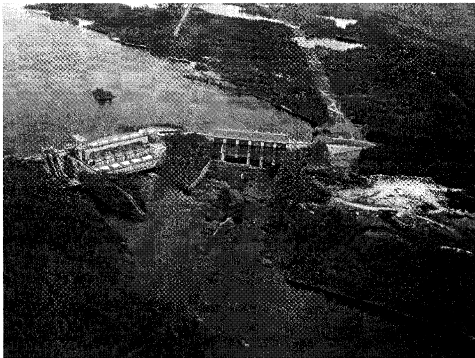
Photo A.7 : Centrale Chute-du-Diable – PK 44
