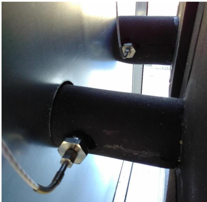
Abbildung 77: Montage der Temperatursensoren auf der Hydraulikseite (Messstellen  $T_{CE}$  und  $T_{CA}$  als Beispiel)
