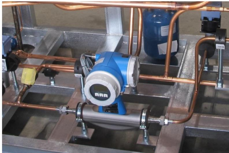
Abbildung 76: Montage des Durchfluss-Messgeräts
