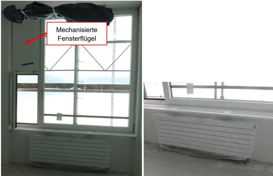
Abbildung 23: Fassadenraster der Bürozone und Integration Heizkörper Zehnder Nova Neo
