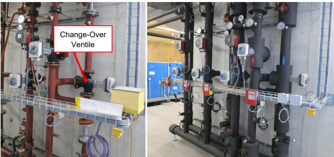
Abbildung 19: Change-Over Schaltung in der Hauptzuleitung zu den Heiz- und Kältegruppen (unisoliert (links) und isolierter Zustand (rechts))
