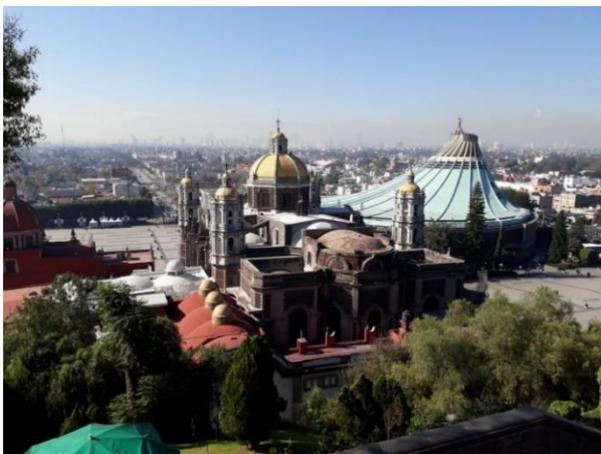
**Figura 1.** Antigua Basílica de Guadalupe sujeta al fenómeno de deformación en suelos blandos.
