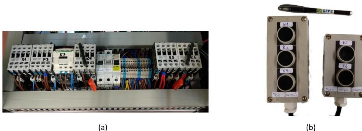
Figura 5.27 – Ligação do circuito de comando: (a) contadores e disjuntores; (b) botões.
