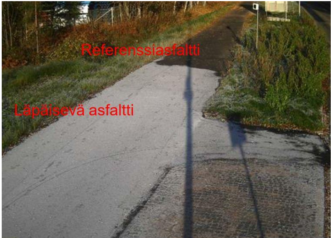
Kuva 5. VTT:n pilottikohde Helsingin Kuninkaantammessa. Etualalla on avointa asfalttia ja takana tavallista asfalttia (Rinta-Hiiro 2019).
