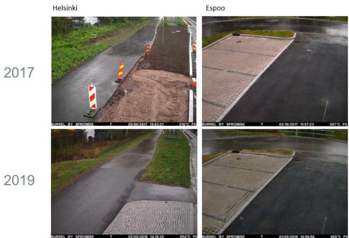
Kuva 8. VTT:n pilottikohteet Helsingissä ja Espoossa. Helsingin kohteessa etualalla on läpäisevää asfalttia ja Espoossa avointa asfalttia on keskellä pysäköintialuetta (Rinta-Hiiri 2019).
