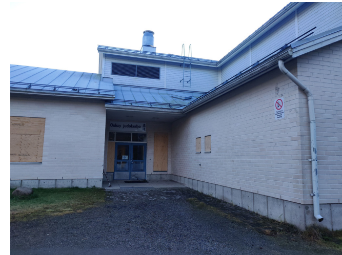
Kuva 18. Laajennusosan sisäänkäynti Korvensuoranpolun puolelta. Liikuntasali on Judo-yhdistyksen käytössä.
