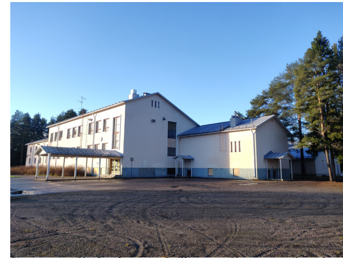
Kuva 16. Koulurakennus koillisesta. Kuvasta näkee hyvin matalemmän koillissiiven.
