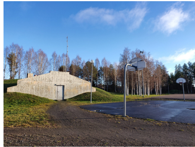
Kuva 21. Purettavan väestönsuojan sisäänkäynti.
