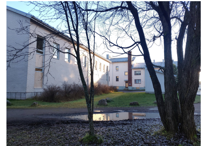
Kuva 19. Laajennusosa kuvattuna lännestä.
