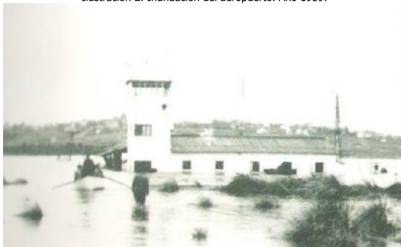
Ilustración 2. Inundación del aeropuerto. Año 1959.
