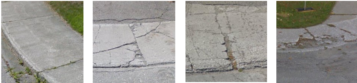
Figure 28: Échantillons représentatifs de chaque classe pour l'état du revêtement (gauche à droite) : bon état, lézardes superficielles, crevasses profondes/larges, très endommagé/impraticable
