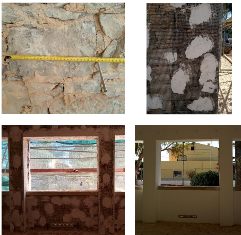
Figura 6.11: Solução de reforço, tal como foi executada.
