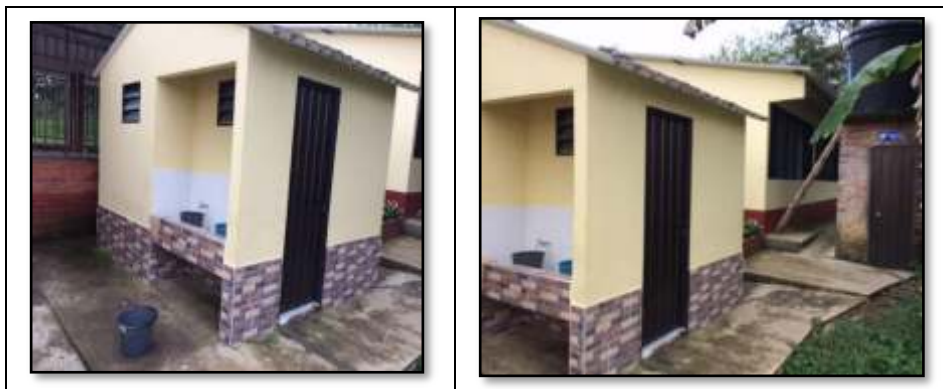
Ilustración 4: Registro fotográfico de Sede E, el Bosque. La batería sanitaria se localiza en la parte posterior del plantel educativo y se divide de niños y niñas y el baño de la docente se encuentra al interior del edificio de la biblioteca. Fuente: Autor
