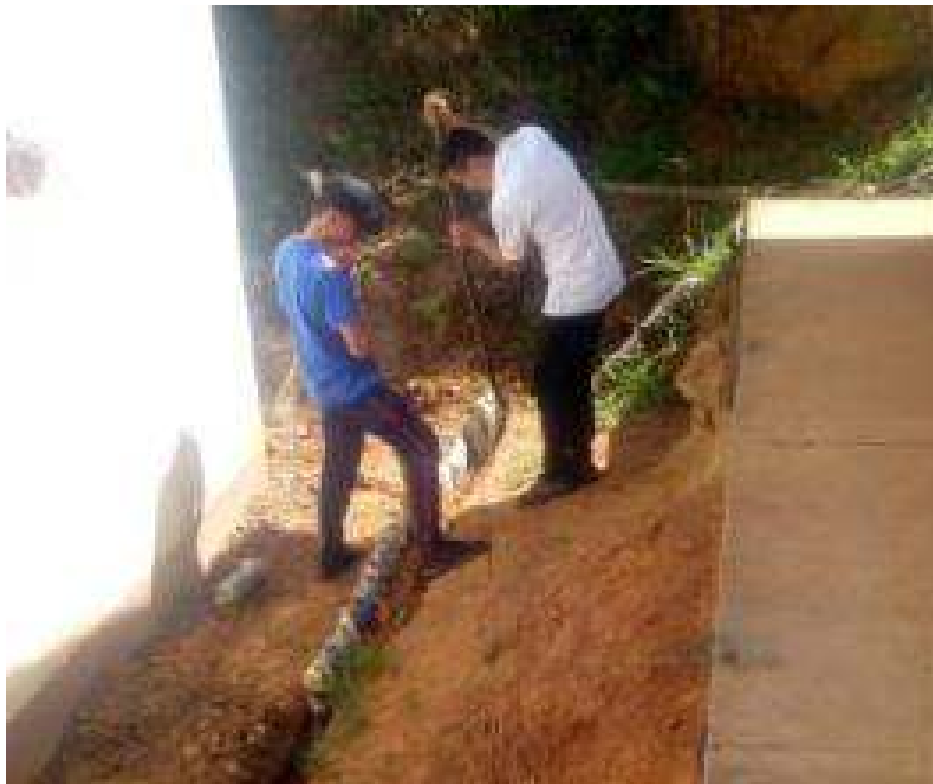
Figura 15 Apoyo de las botellas compactadas como sardineles de contención Fuente: Autores
