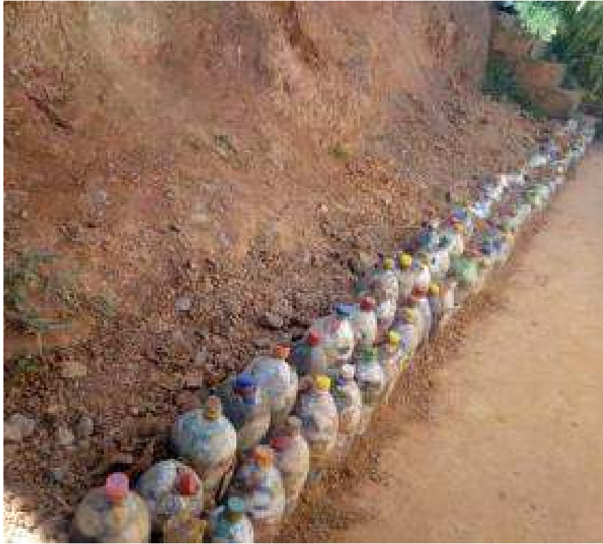
Figura 16 Apoyo de las botellas compactadas como sardineles de contención Fuente: Autores
