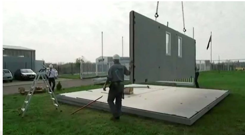
Figura 14: Establecimiento de la primera pared.
