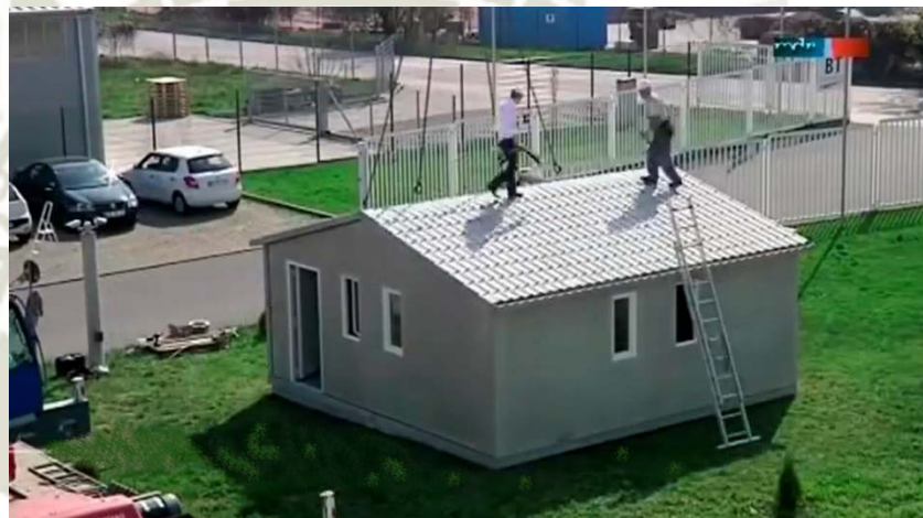
Figura 21: Acabado total de la casa prefabricada
