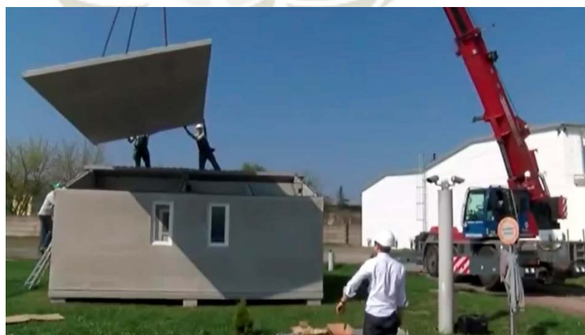
Figura 19: Colocación de la loza del techo
