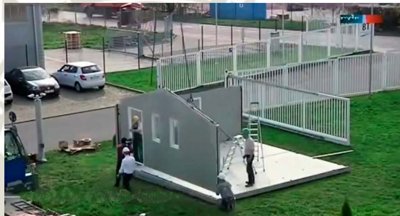
Figura 15: Establecimiento de dos paredes.
