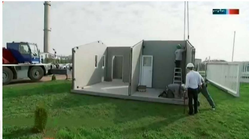
Figura 17: Instalación de paneles laterales y divisorios.
