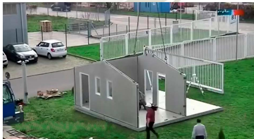
Figura 16: Instalación de cuatro paneles
