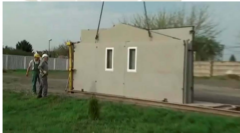
Figura 13: Los paneles pre fabricados.
