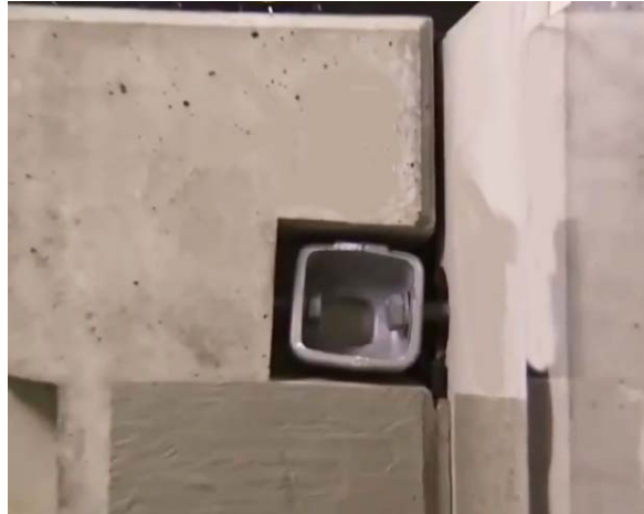
Figura 52: Dispositivo de anclaje en pieza prefabricada. [18]
