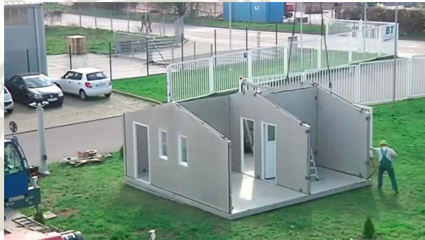
Figura 18: Instalación de todos los paneles laterales y divisorios.
