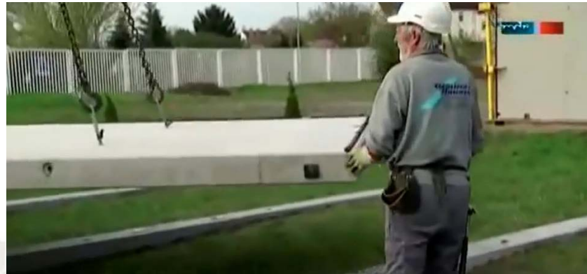
Figura 11: Vigas de Cimentación y loza para el piso.
