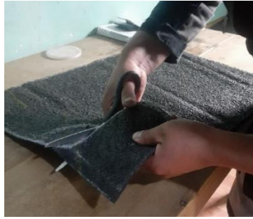
Figura 3.26 Corte de la superficie de la alfombra
