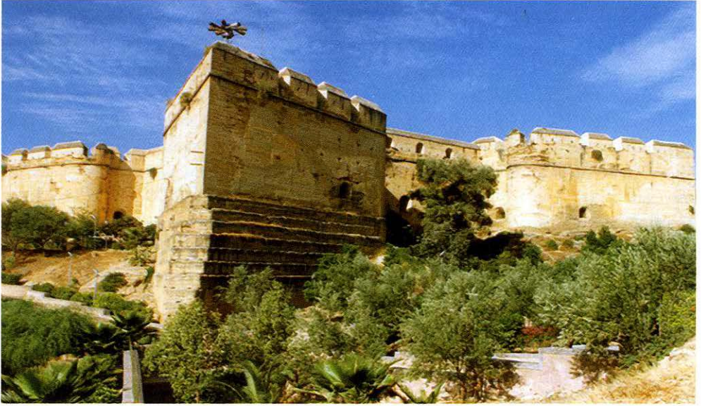
Fig. 2. Vista del bordj antes de su restauración.
