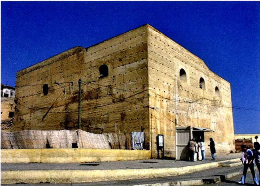
Fig. 19. Burğ Bütüfl, vista de las fachadas exteriores.
