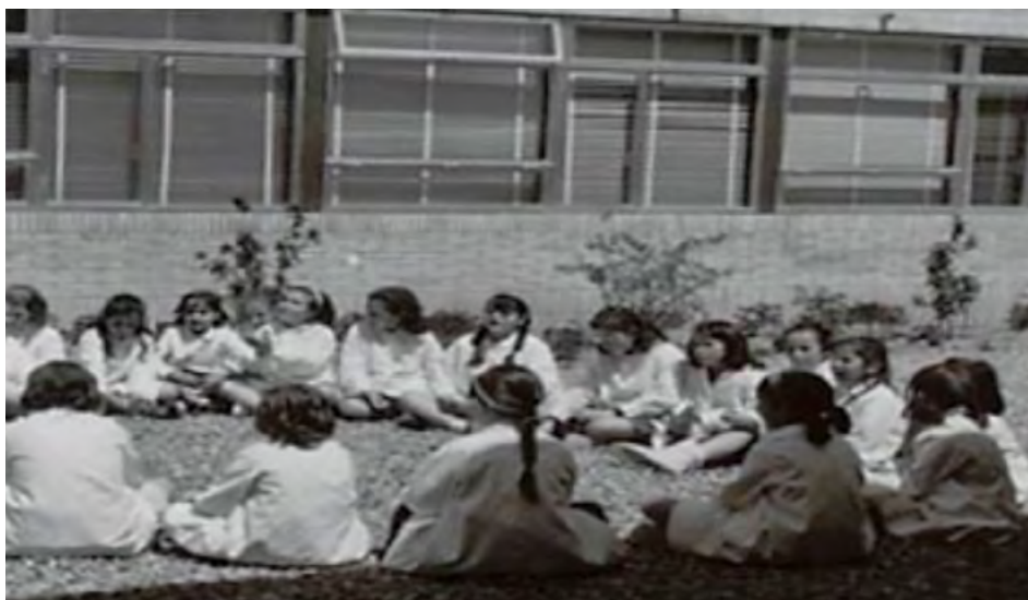
Fotografías 5 y 6. Terrazas de las aulas del Instituto Vértas, Madrid, 1964 (FRM 13)
