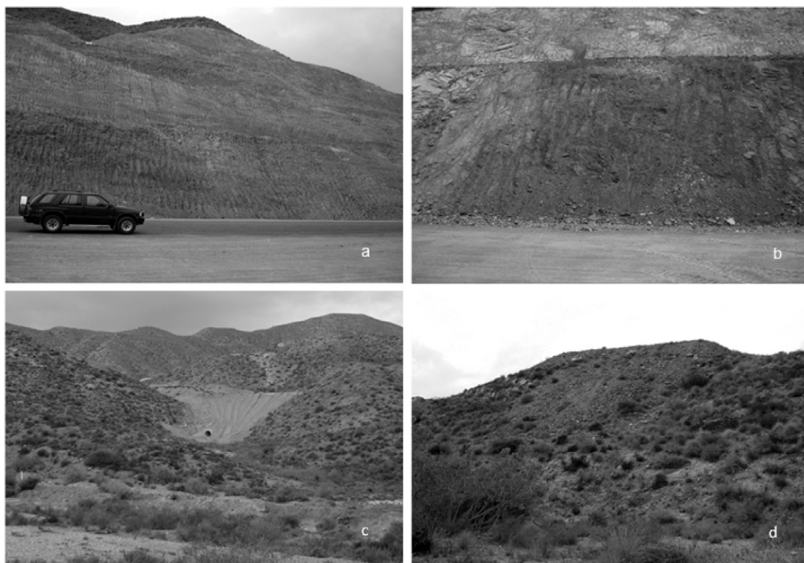
▲ FIGURA 7. Taludes de desmonte (a, b) y terraplén(c) originados por la construcción de la AP-7 Cartagena-Vera; y desprendimiento natural (Rambla de los Quiñoneros) (d).
