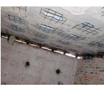
(d) Bottom surface of the slab
