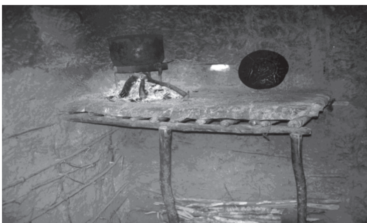
Figura 4: perfil da cozinha das casas que são construídas de taipa.
